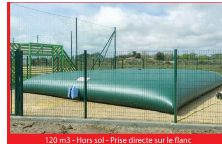
Citerne incendie (Source : Akuo)
